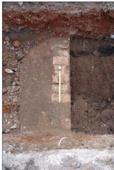
Imatge 16: Fonamentació UE 131, vista des del sud.
