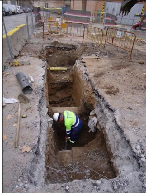
Imatge 26: Vista del tram de rasa oberta al carrer Cristòbal de Moura, entre els carrers de Provençals i Selva de Mar, i procés de neteja dels serveis localitzats.
