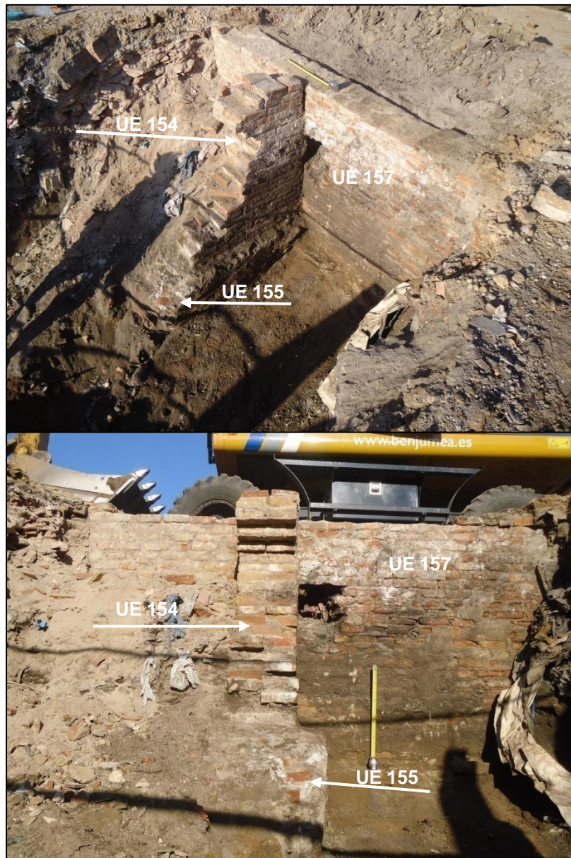
Imatge 25: Mur UE 157, contrafort UE 154 i fonamentació UE 155. Imatge superior, vista des del sud-est. Imatge inferior, vista frontal.
