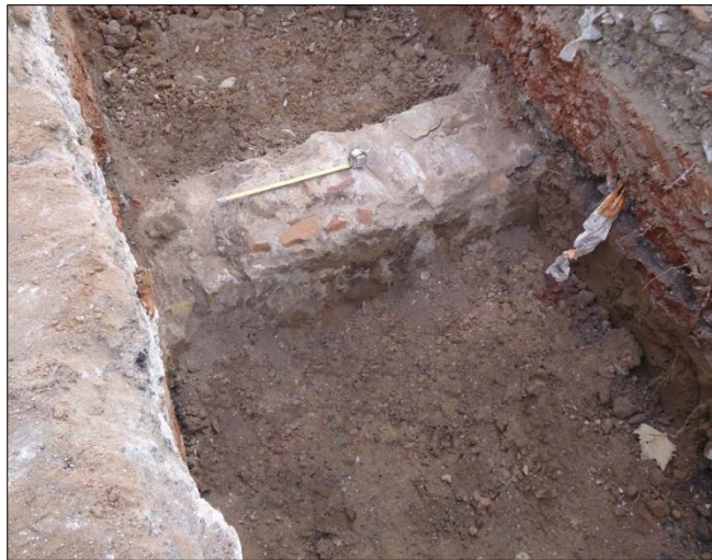
Imatge 15: Fonamentació UE 129, vista des del sud.
