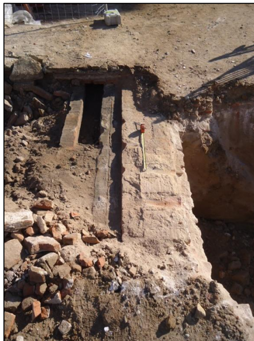
Imatge 23: Fonamentació UE 151 i canal UE 153, vista des del nord-oest.
